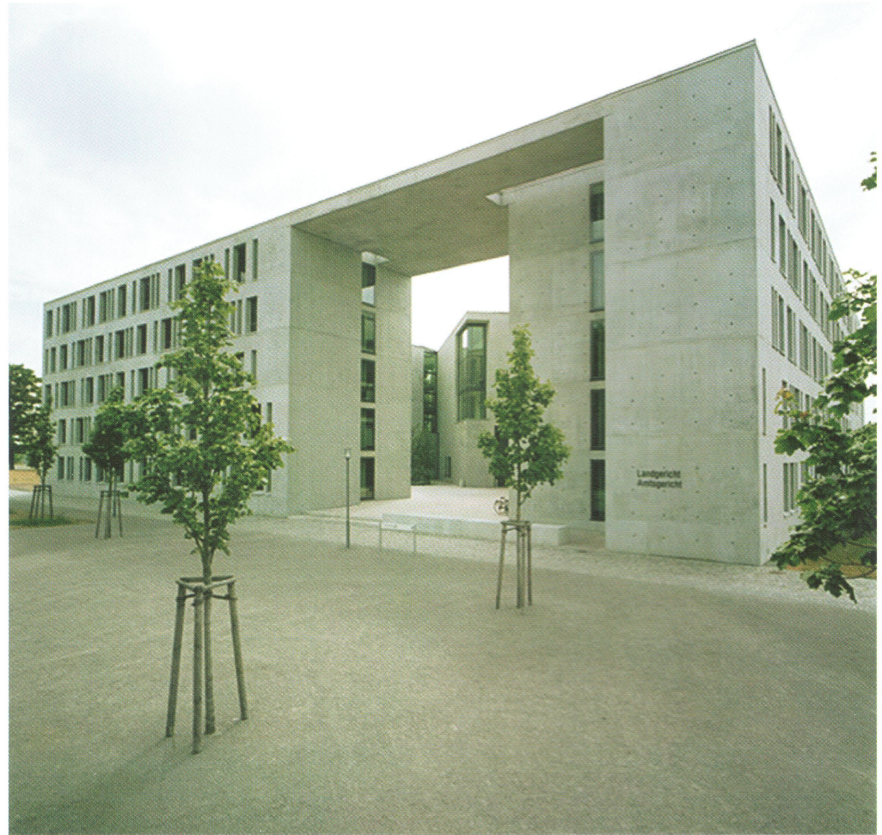
Рис. 8. Здание участкового и земельного суда во Франкфурте-на-Одере с монолитными внешними стенами из бетона класса LC16/18 D1,2, B&J Architekten Berlin (Фото: Liapor)
