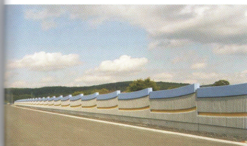
Рис. 2. Шумозащитная стена из беспесчаного легкого бетона (Фото: Liapor)
