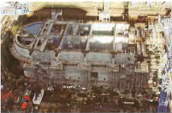
Bild 10: Blick in das Trockendock mit fertig betonierten Wänden eines Schenkels des MPU Heavy Lifters [21]
